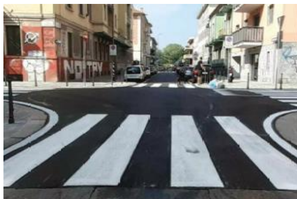
Esempio di intersezioni stradali rialzate
